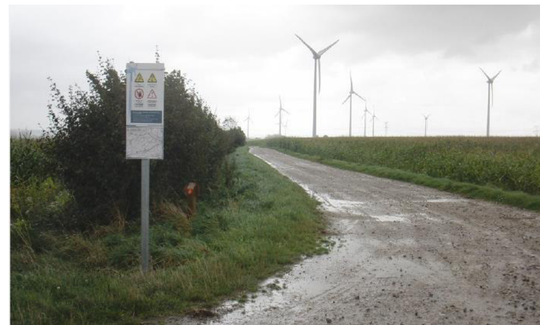
Figure 9. Exemple de panneau d'information sur les risques et les consignes de sécurité placé à proximité des éoliennes (Source : RP Global)
